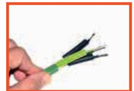
Schrumpfschläuche 35 mm über die vorbereiteten Pressverbinder schieben.
