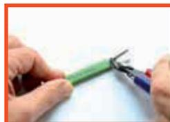
Schutzleiterlitze an der Heizleitung abschneiden.
