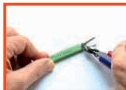
Schutzleiterlitze an der Heizleitung abschneiden.
