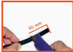
Anschlussleitung wie abgebildet auf 65 mm den äußeren Mantel entfernen.
