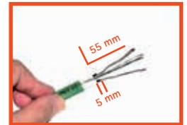
Litzen freilegen, verdrillen und restliches Heizelement um 55 mm kürzen, dabei aber einen Rest von 5 mm stehen lassen.
