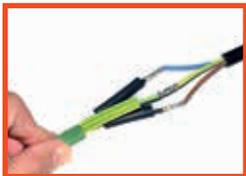
Das andere Ende der Pressverbinder über die blanken Kupferleiter der Anschlussleitung schieben und aufpressen.
