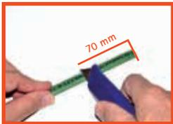
Heizleitung gerade abschneiden und 70 mm der äußeren Isolierung entfernen.
