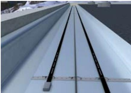
Mehrfachverlegung bei Dachrinnen über 240 mm Breite, z.B. bei Shedrinnen, Befestigung mittels Abstandshalter ASH.
