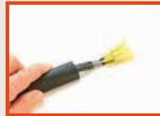
Die 3 Schrumpfschläuche (120 mm) sowie den Abzweigschrumpfschlauch (T-Abzweig) aufschieben, und über die abisolierten Heizbandenden die Pressverbinder schieben.
