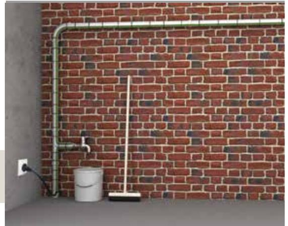
Bei Leitungen, die fetthaltige Abwässer vom Abfluss zum Fettabscheider transportieren, setzt sich bei zu niedrigen Rohrtemperaturen Fett an der Rohrwand ab und verstopft die Leitungen. Abhilfe schafft eine leistungsstarke elektrische Begleitheizung, die unter der Wärmedämmung verlegt wird. (s. DIN EN 1825-2) Fette können sich somit nicht mehr ablagern.
