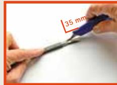
Isolierhülle des Heizelements um 35 mm zurückschneiden und Litzenenden abisolieren.
