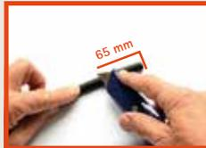
Anschlussleitung gerade abschneiden und 65 mm der äußeren Isolierung entfernen.
