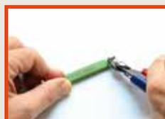
Schutzleiterlitze an der Heizleitung abschneiden.
