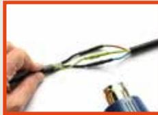
Die Schrumpfschläuche mittig über die Pressverbinder schieben und aufschumpfen.
