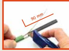
90 mm der inneren Isolierhülle einschneiden und vom Heizelement entfernen.
