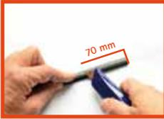
Heizleitung gerade abschneiden und 70 mm der äußeren Isolierung entfernen.
