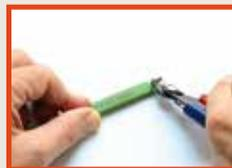
Schutzleiterlitze an der Heizleitung abschneiden.
