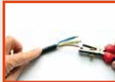
Anschlussleitungen freilegen und wie abgebildet 10 mm abisolieren.
