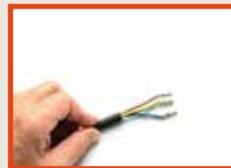
Pressverbinder auf Anschlussleitung schieben und aufpressen. Achtung: vor dem Verpressen den großen Schrumpfschlauch (220 mm) über eines der Kabel schieben, da dies im nachhinein (nach dem Verpressen) nicht mehr möglich ist!
