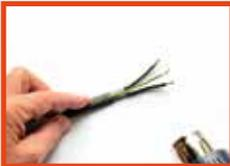
Die schwarzen Schrumpfschläuche und den grün/gelben Schrumpfschlauch (Ø 4 mm, Länge 45 mm) stramm bis ans Ende der Litzen schieben und aufschumpfen.
