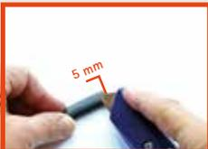
Heizleitung gerade abschneiden und 5 mm der äußeren Isolierung entfernen.
