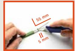
Litzen freilegen, verdrillen und restliches Heizelement um 55 mm kürzen, dabei aber einen Rest von 5 mm stehen lassen.
