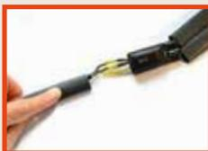
Die drei Heizbandenden gemäß Abbildung mit Pressverbindern mit der entsprechenden Gegenseite verpressen.
