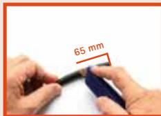
An der Anschlussleitung wie abgebildet auf 65 mm den äußeren Mantel entfernen.
