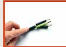
Pressverbinder auf Anschlussleitungen schieben und aufpressen, Schrumpfschläuche (Ø 8 mm, Länge 40 mm) über die Leitungen schieben.
