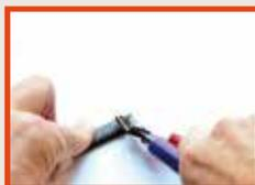
Schutzleiterlitze an der Heizleitung abschneiden.
