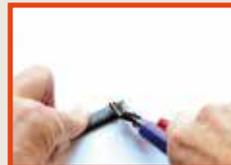
Schutzleiterlitze an der Heizleitung abschneiden.
