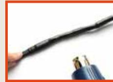
Zusätzlich Schrumpfschlauch (220 mm) über die gesamte Verbindungsstelle schieben und aufschumpfen.
