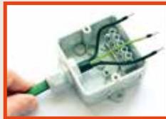
Verschraubung am Gehäuse anbringen, Heizleitung mit aufgeschobener Dichtung und Schraubkappe einsetzen und nach Justierung auf die nötige Länge anziehen. Versorgungsleiter und Zuleitung (L, N, PE) können verbunden werden.
