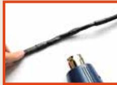
Großen Schrumpfschlauch (180 mm) für äußere Isolierung und Abdichtung über Verbindungsstelle schieben und aufschumpfen.
