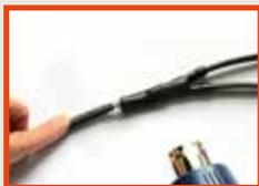
Abzweigschrumpfschlauch mit dem Heissluftfön erwärmen, bis diese gleichmäßig an den 3 Heizbändern anliegt und etwas Schmelzkleber an den Enden austritt. Achtung nicht überhitzen!
