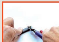
Schutzleiterlitze an der Heizleitung abschneiden.
