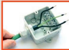
Verschraubung am Gehäuse anbringen, Heizleitung mit aufgeschobener Dichtung und Schraubkappe einsetzen und nach Justierung auf die nötige Länge anziehen. Versorgungsleiter und Zuleitung (L, N, PE) können verbunden werden.
