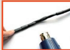
Großen Schrumpfschlauch (180 mm) für äußere Isolierung und Abdichtung über Verbindungsstelle schieben und aufschumpfen.
