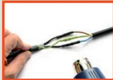
Die Schrumpfschläuche mittig über die Pressverbinder schieben und aufschumpfen.
