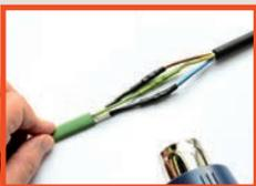
Schrumpfschläuche mittig über die Pressverbinder schieben und aufschumpfen.
