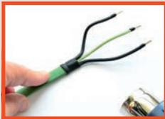
Adernhülsen auf Anschlussleitungen quetschen und Schrumpfschlauch wie zu sehen schrumpfen. Beim Aufschrumpfen des kurzen Schrumpfschlauhes (20 mm) den Bereich zwischen den Leitern mit einer Spitzzange zusammendrücken und somit miteinander verkleben.
