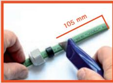
Heizleitung gerade abschneiden, Verschraubung mit Heizbanddichtung aufschieben. 105 mm der äußeren Isolierung entfernen.
