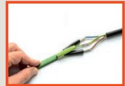
Schrumpfschläuche (Ø 8 mm, 40 mm lang) über die vorbereiteten Pressverbinder schieben und das andere Ende der Pressverbinder mit den blanken Kupferleitern der Anschlussleitung verpressen.
