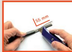
Heizelement 55 mm entlang beider Litzen auftrennen.
