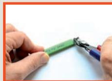
Schutzleiterlitze an der Heizleitung abschneiden.
