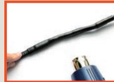
Zusätzlich Schrumpfschlauch (220 mm) über die gesamte Verbindungsstelle schieben und aufschumpfen.
