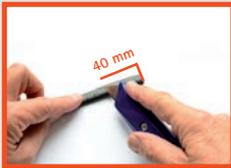
Heizleitung gerade abschneiden und 40 mm der äußeren Isolierung entfernen.
