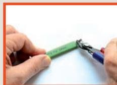
Schutzleiterlitze an der Heizleitung abschneiden.
