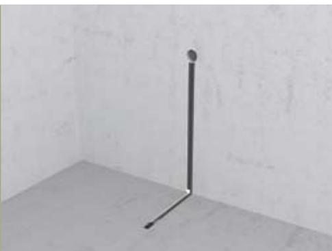
Vor Beginn der Verlegung müssen Boden und Wand mit einem Schlitz versehen werden, so dass 2 Leerrohre (für Kaltleiter und Temperaturfühler) mit ausreichender mechanischer Festigkeit darin bündig verbaut
